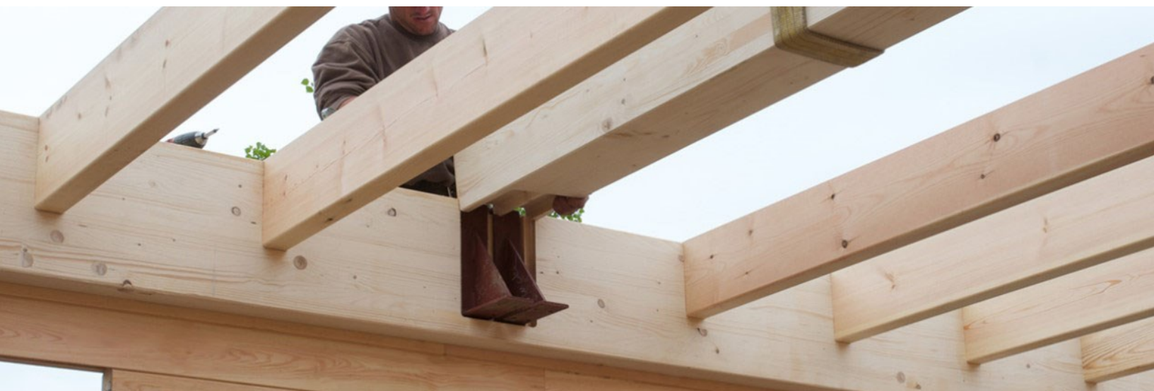
Een moerbalk waarin een andere moerbalk en een aantal roosteringen rusten.
