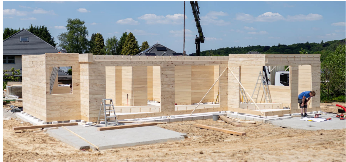
Montage van een woning in Dworp: benedenverdieping klaar na zes uur
